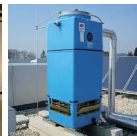
Verdunstungskühlturm Solution / Axima
